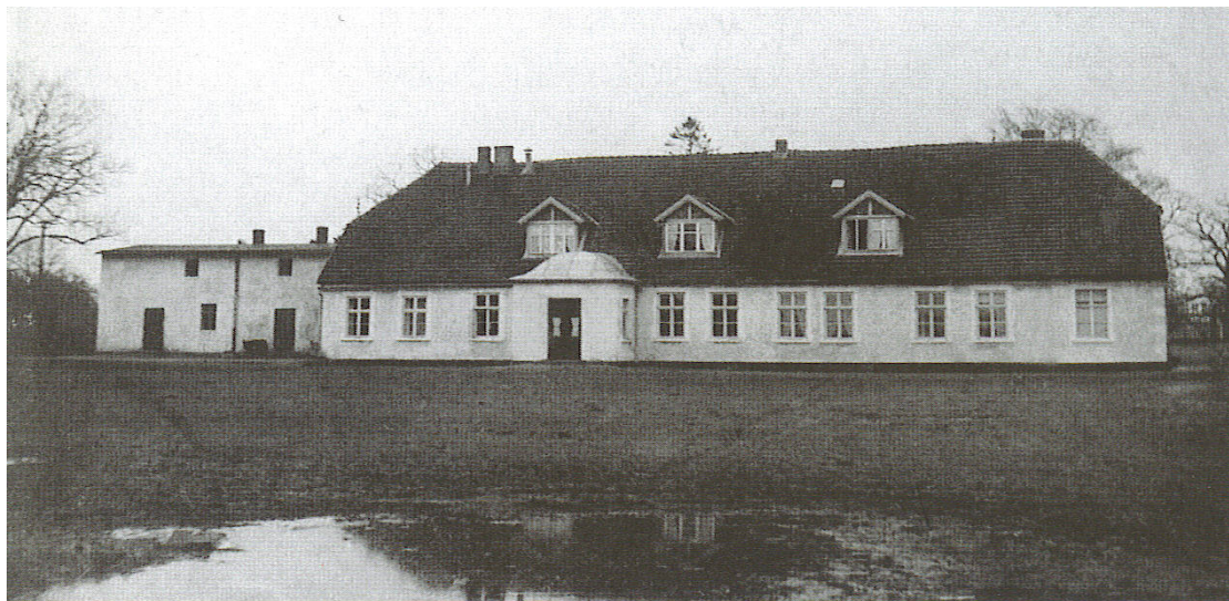
Inspektorenhaus auf dem Sandhof
